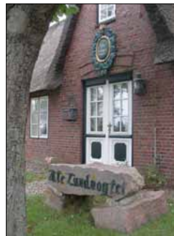
Das älteste Haus im Ort: Die Alte Landvogtei
