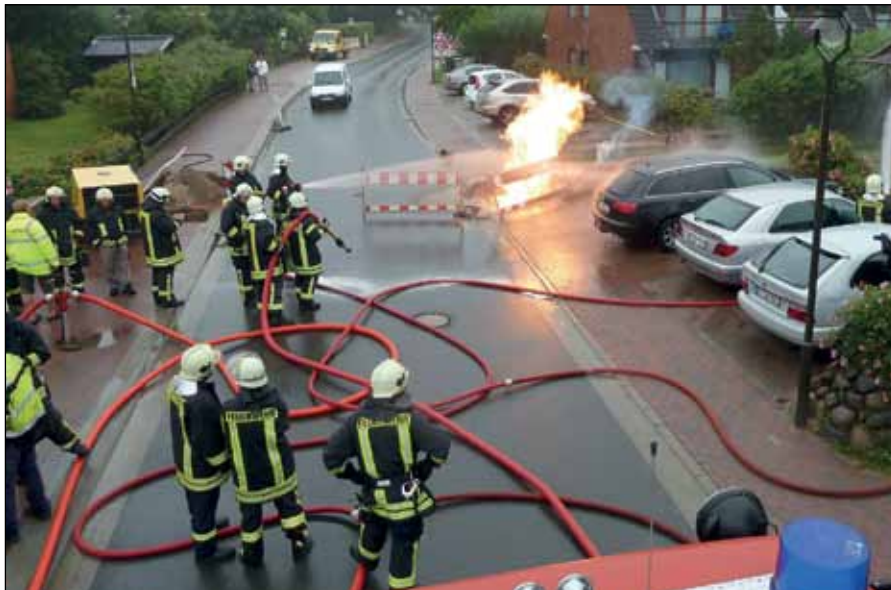
Großalarm aufgrund einer brennenden Gasleitung
