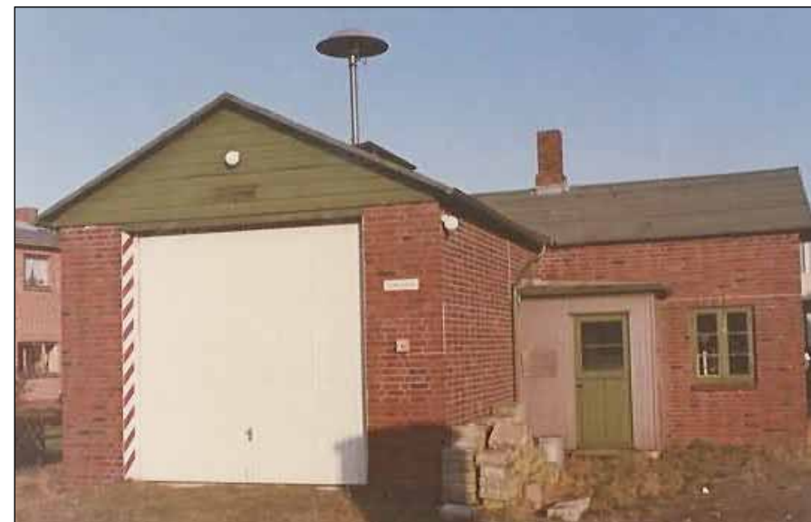
1944 wird an der Boy-Nielsen-Straße ein neues Gerätehaus gebaut
