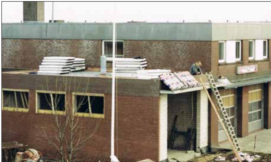
Der Anbau am Gerätehaus nimmt Gestalt an
